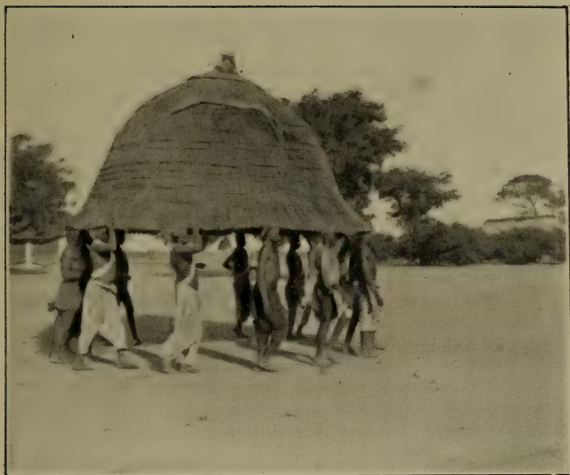
CASE DÉMONTABLE DES INDIGÈNES DE FORT-ARCHAMBAULT.
